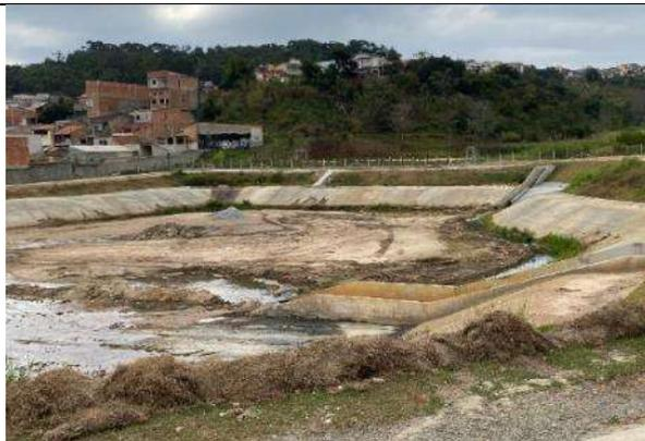
**Figura 97 – Reservatório de detenção**
