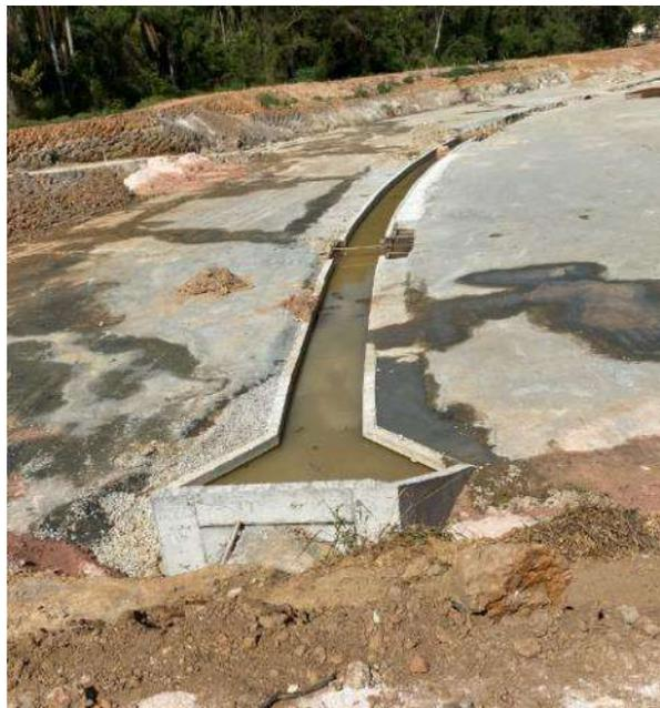
**Figura 92 – Canal no talvegu da bacia de detenção**
